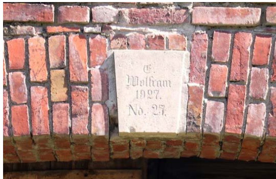
Schlussstein im Torbogen der Mühle
